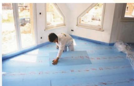
**AVANTAGES :** Très hautes performances thermiques - Pose sans polyane - Insensible à l'humidité - Résistance à la compression et au fluage - Pose directe de carrelage en technique dite scellée - Compatible avec des chauffages intégrés à eau, électrique ou réversibles • Disponible en épaisseurs 30 mm ( $R=0,9m^2.K/W$ ) à l'épaisseur 100 mm ( $R=2,95m^2.K/W$ ).
