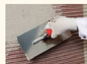
Enduisage armé sur toute la façade
