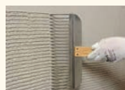
Encollage en plein pour supports plans
